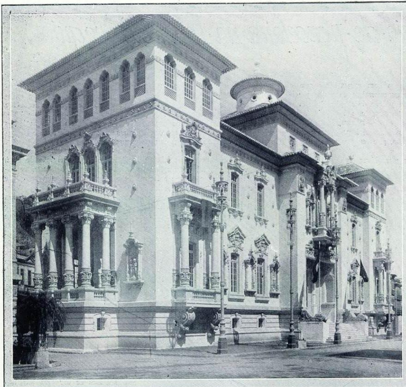
FACHADA PRINCIPAL DO PALACIO DA FIAÇÃO E TECELAGEM
