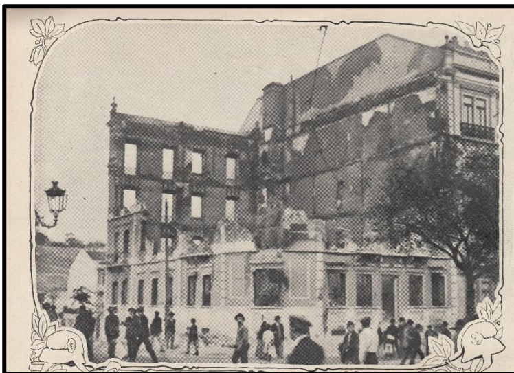
Fig. 10: Prédio destruído na Avenida da Liberdade. ( IP , 17 de outubro)
