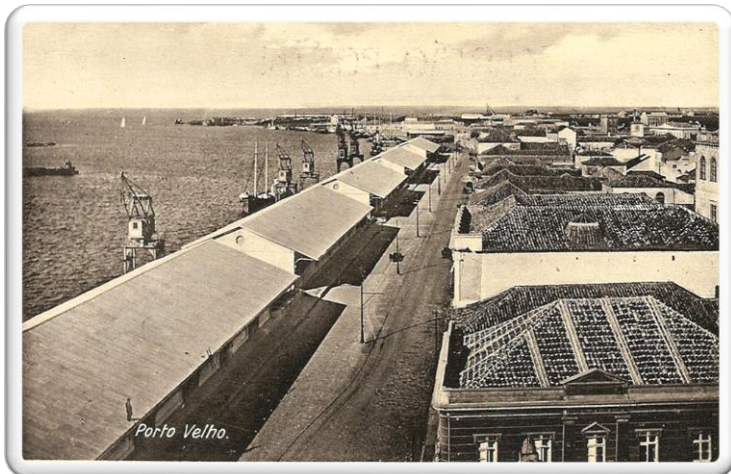
Figura 44 Rua Riachuelo e o Cais do Porto Velho com os armazéns construídos. Editor R. Strauch/Livraria Rio-Grandense, década de 1930. BV.
