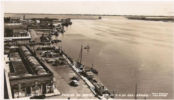
Figura 55 Doca do Mercado Público e Rincão da Cebola, Foto Postal Colombo, cerca de 1959-60. LHT.
