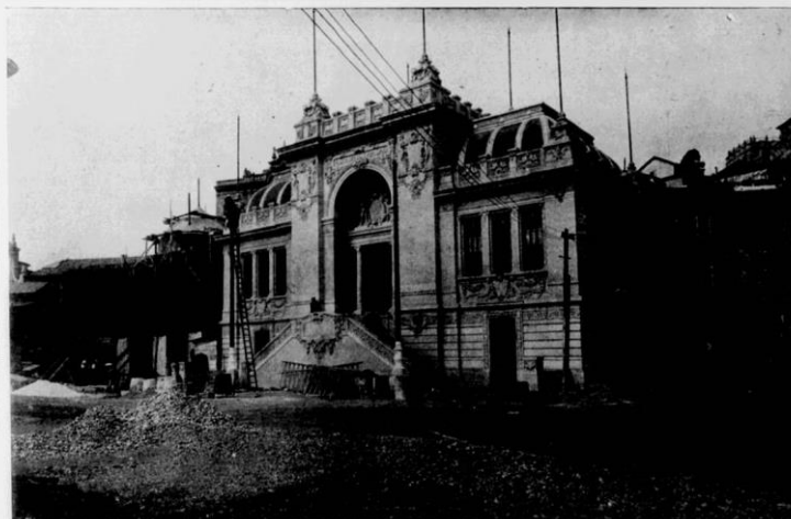
PAVILHÃO DA ADMINISTRAÇÃO, QUANDO SE KETIRAVAM OS ANDAIMES
