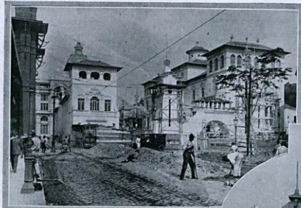
1) Aspecto de alguns dos edifícios, apanhado do lado da rua D. Manoel.
