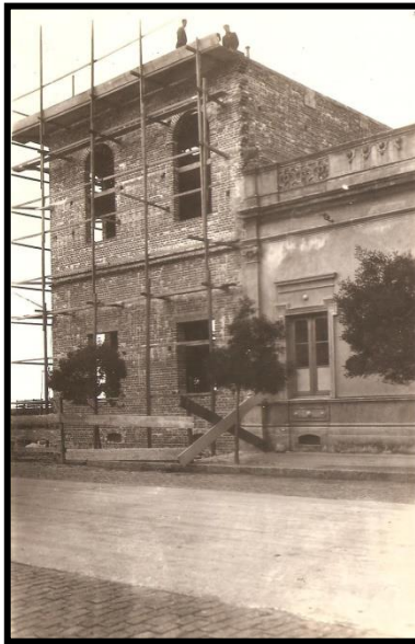
- obras de expansão do prédio -
